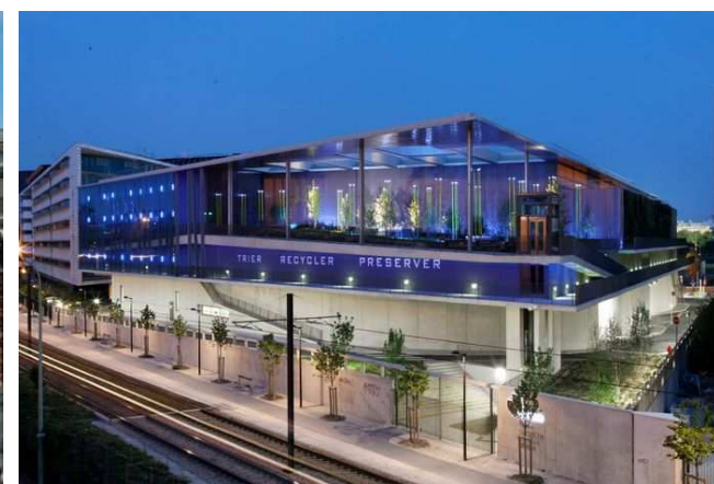
Centre de traitement des déchets Paris XVem Architecte AA'E MOA Svctom
