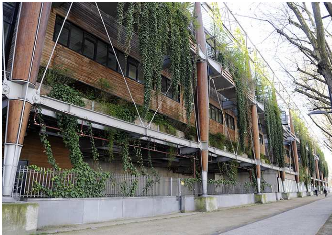
Centre de traitement des déchets Isseane d'Issy Les Moulineaux Architecte Dubosc et Landowski MOA Syctom
