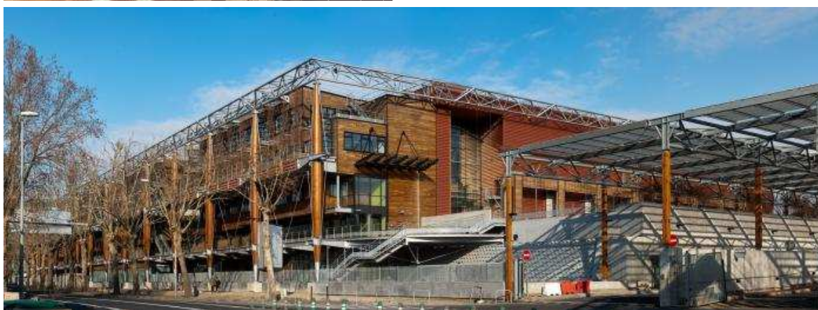
Centre de traitement des déchets Isseane d'Issy Les Moulineaux Architecte Dubosc et Landowski MOA Syctom
